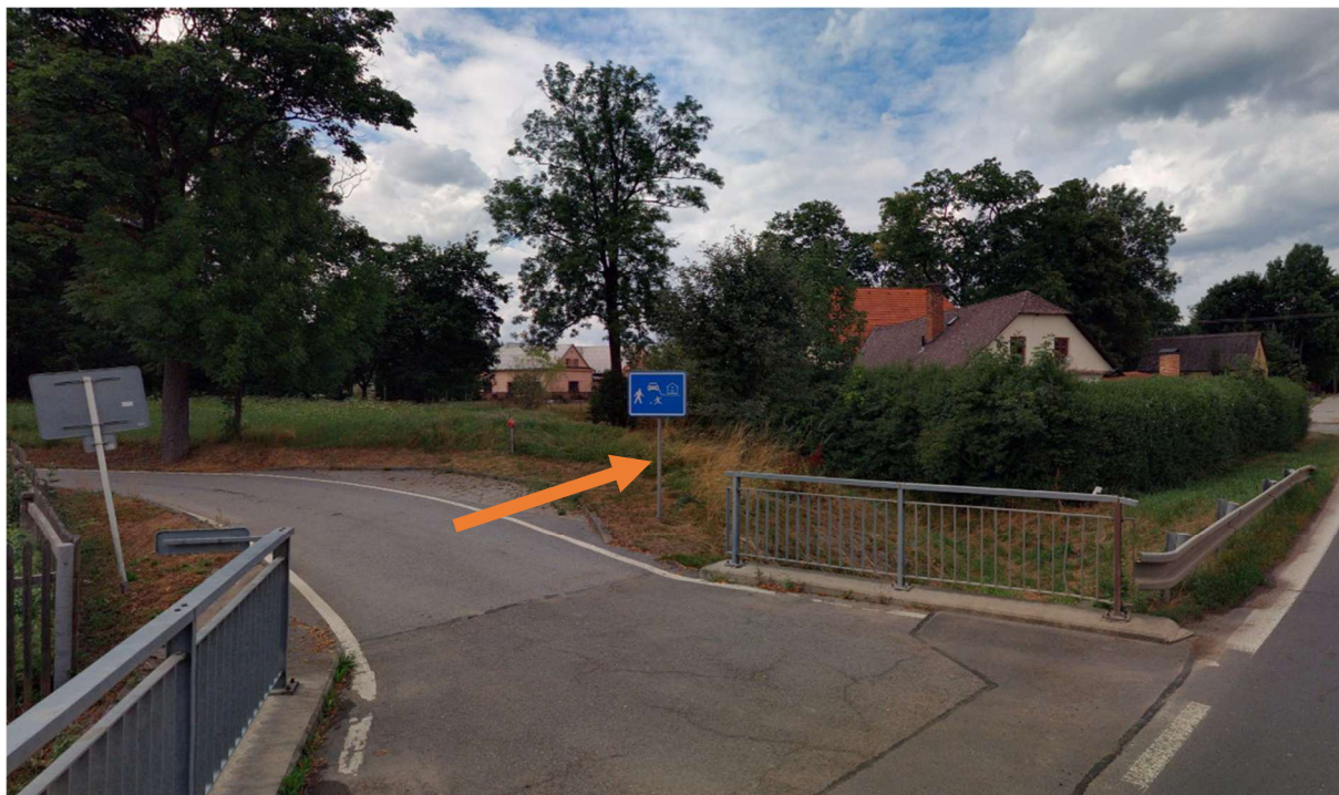
Přístup č. 17 – přístup přes pozemek ve vlastnictví města Svitavy - sjezd z komunikace bude ochráněn panely (geotextílie, podsyp, panely)
